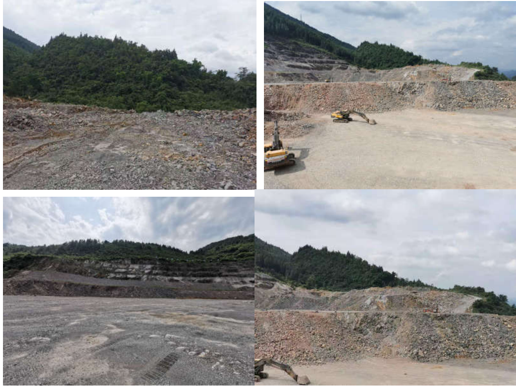
(附项目勘察相关图片)
