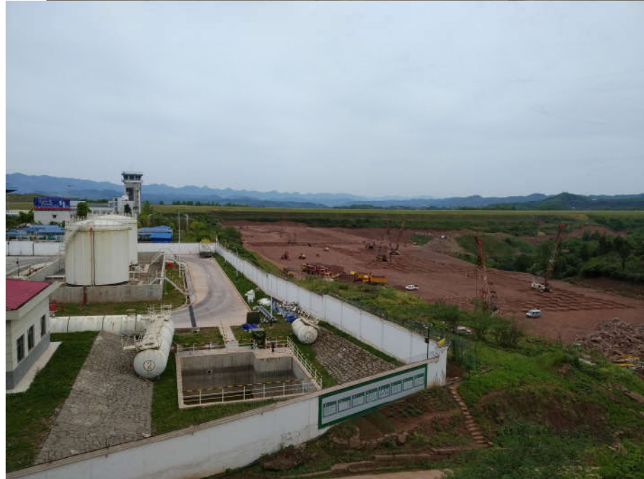
(附项目勘察相关图片)
