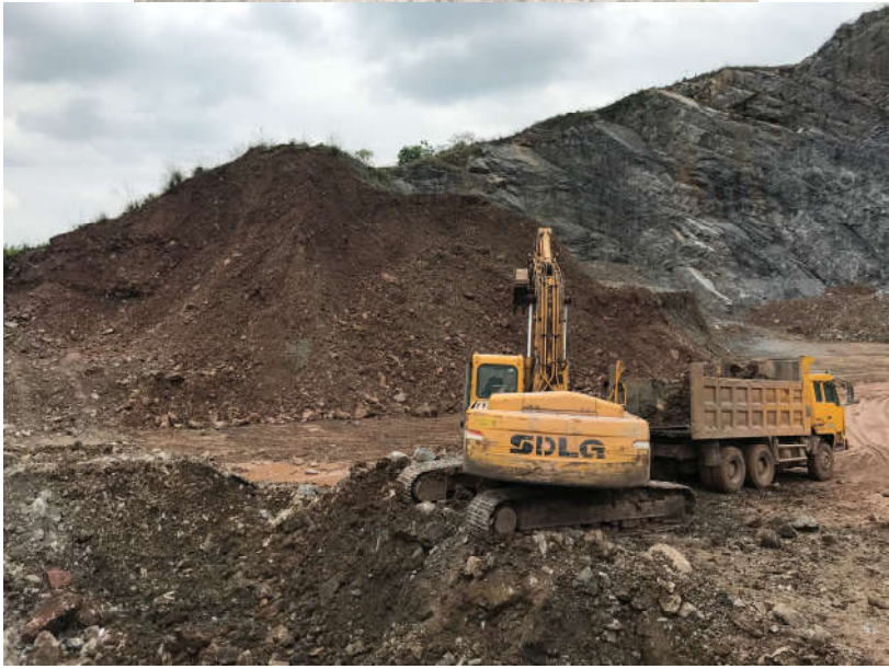
(附项目勘察相关图片)
