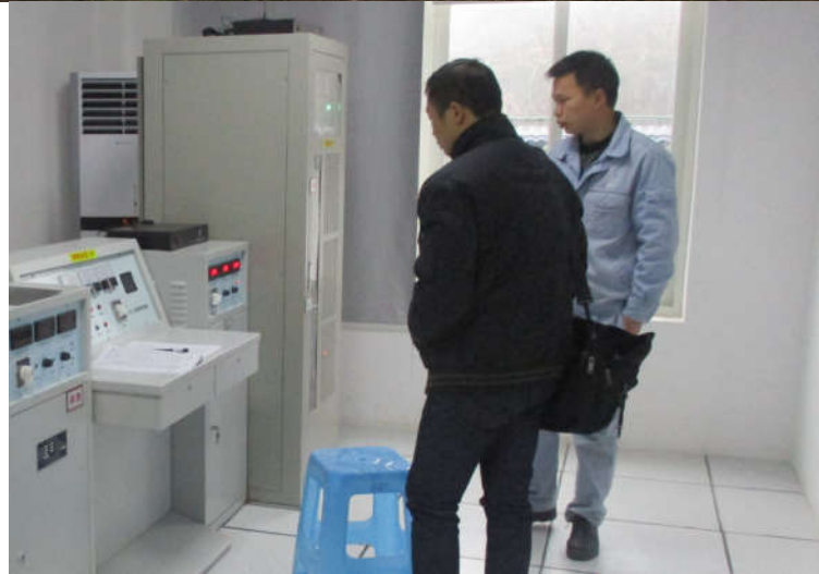
(附项目勘察相关图片)
