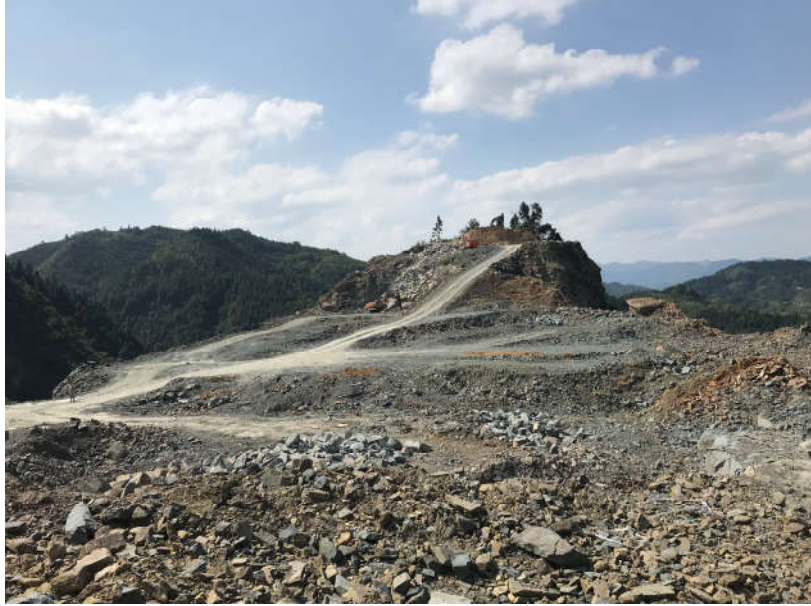
(附项目勘察相关图片)
